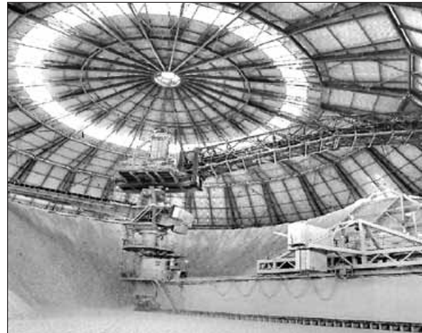
شکل ۲: پروژه‌های احداث کارخانه سیمان به روش «چند بخشی» امکان انتخاب ترکیبی بهینه از تجهیزات را فراهم می‌کند
