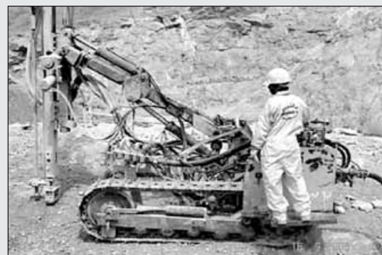
شکل ۲: دستگاه حفاری دریل واگن
